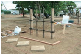
造園工事作業の作品例
